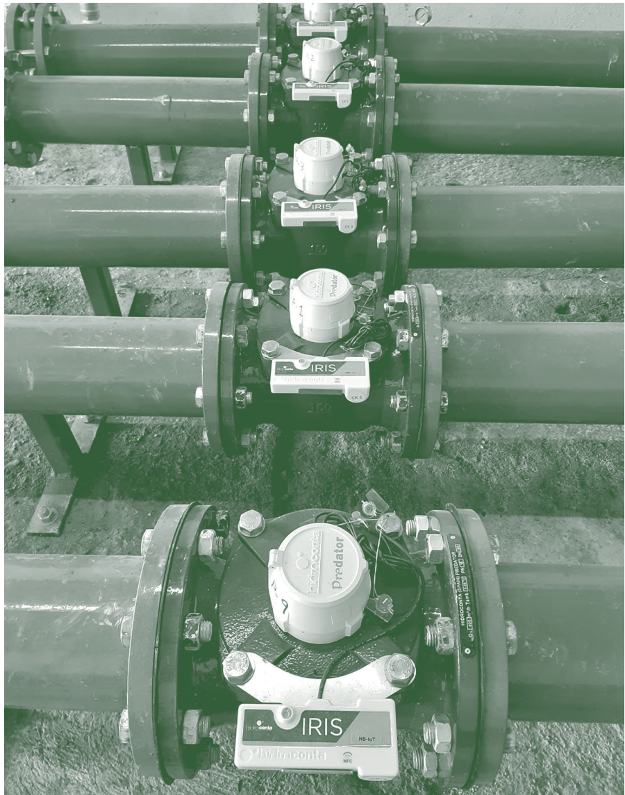
Contadores de agua digitalizados con Iris en la C.R. Cota 400.
